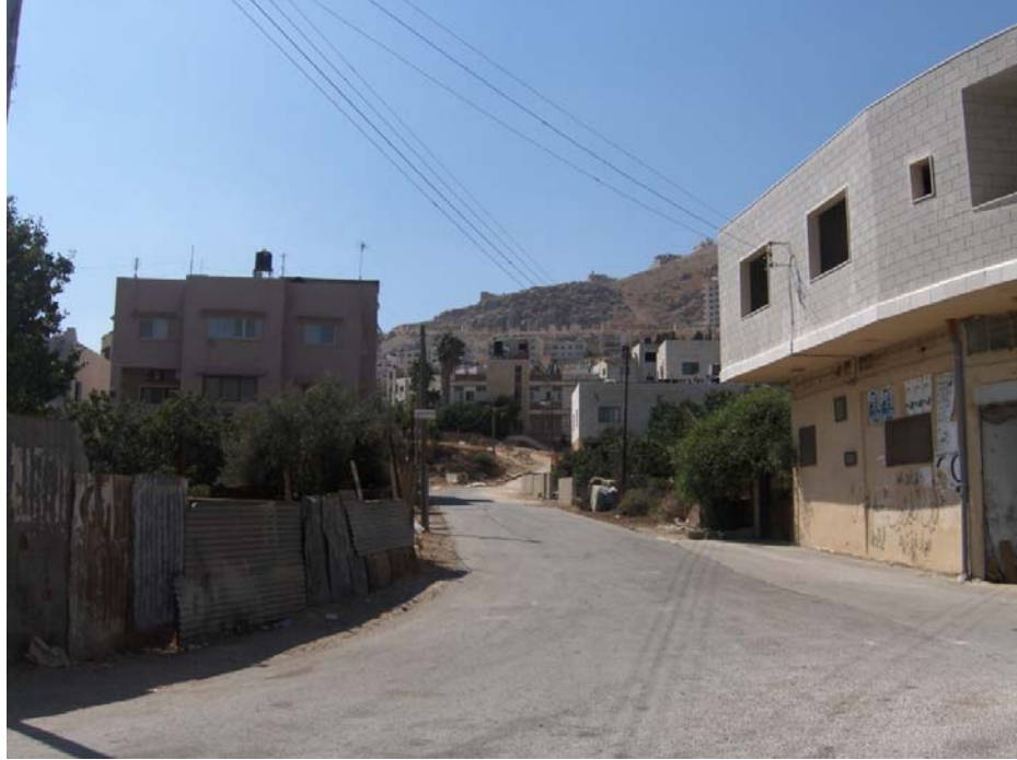
شكل رقم (5،13) : صورة عامة تظهر فيها المباني التي تحد الشارع رقم 4. المصدر: الباحثة.
