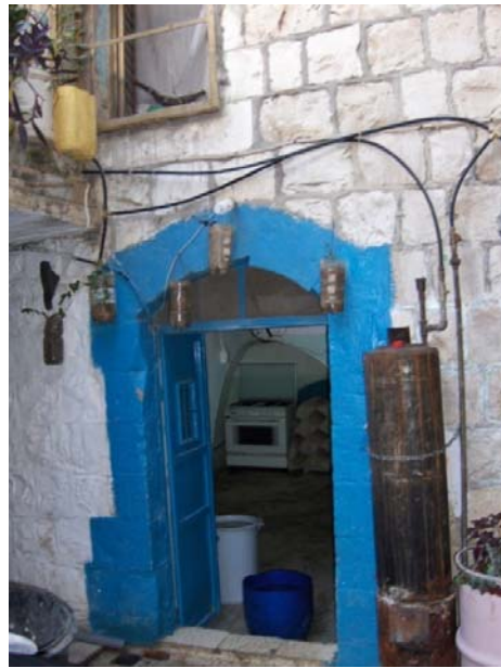
شكل رقم (31.4) : صور تبين عمليات الصيانة الحديثة للمباني القديمة في قرية بلاطة البلد. المصدر: الباحثة.
