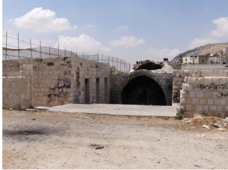
شكل رقم (17.4) : صورة للواجهة الشمالية الرئيسية لمقام النبي يوسف. المصدر : الباحثة.
